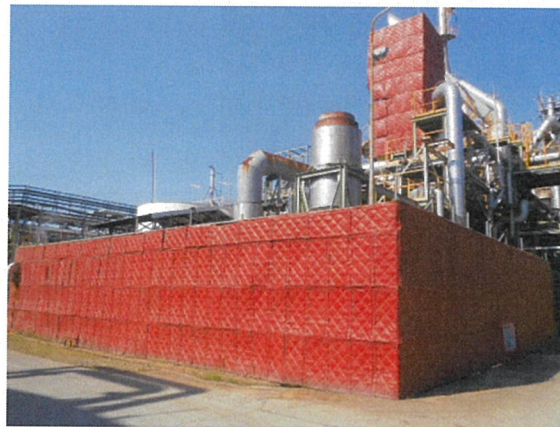
การติดตั้งแผ่นกันเสียงดังจากเครื่องจักร 4140-B1-T1
